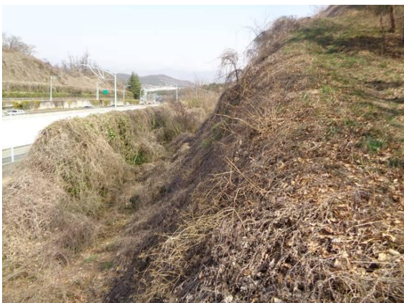
낙석방지울타리 및 하부 전경
