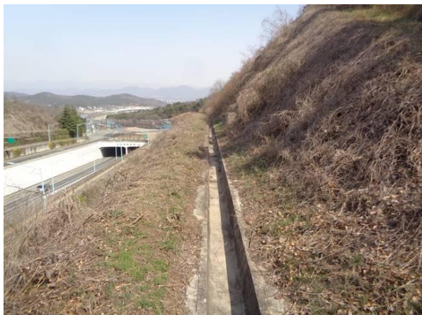
1소단 배수로 전경
