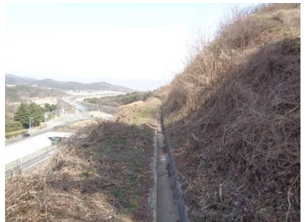
2소단 배수로 전경
